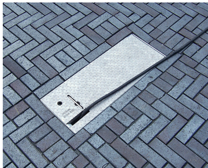
Maksimal belastning på dæksel, jvf. EN124: 12,5 Ton
