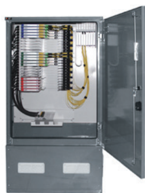
FT 785 Mellem monteret på en betonsokkel
